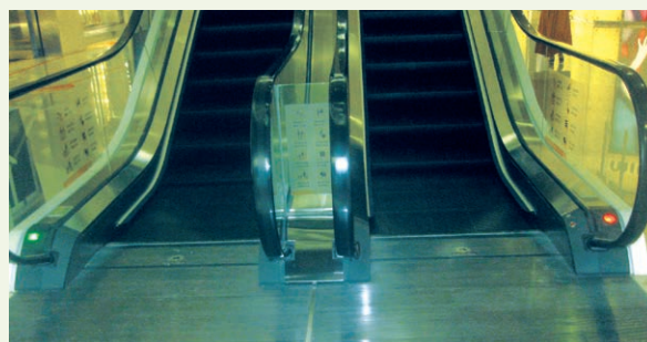
▲ 改造后的沈阳万象城扶梯
